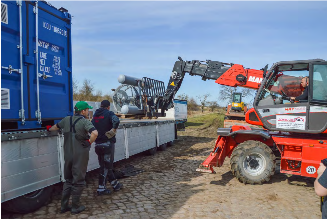
Abb. HKT PT2 Entladung des LKW am Standort
