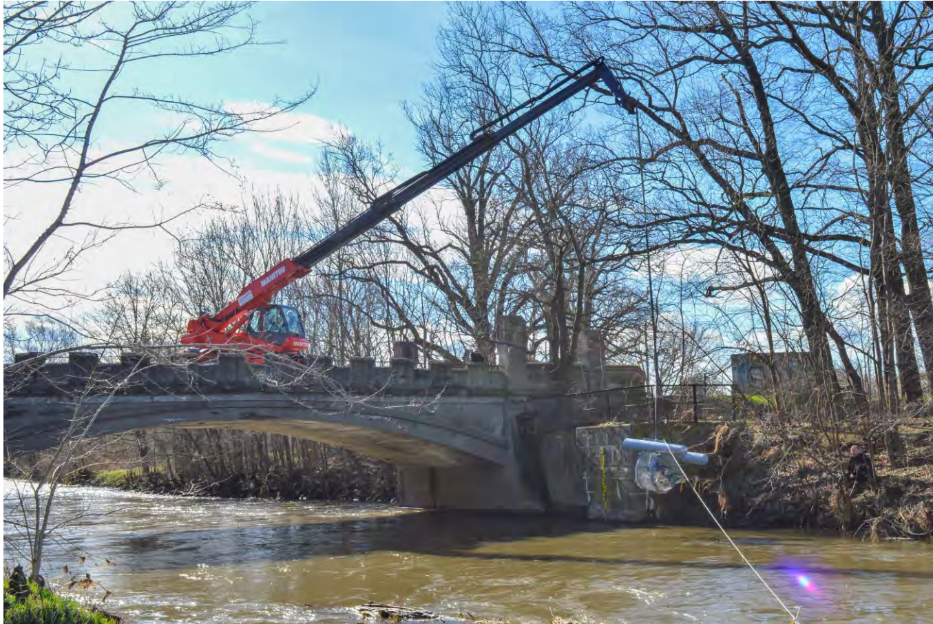
Abb. HKT PT2 Einsetzen des HKT PT2 in Bode
