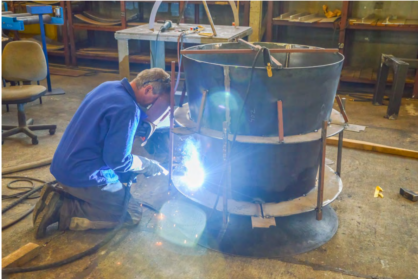
Abb. HKT PT1 Schweißmontage Innenmnatel
