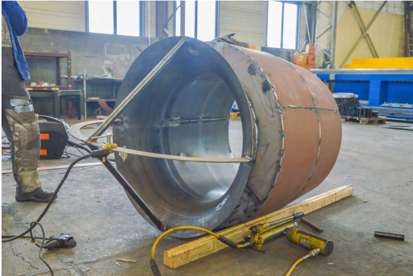
Abb. HKT PT1 Schweißmontage Außenmantel und Fremdkörperschutz
