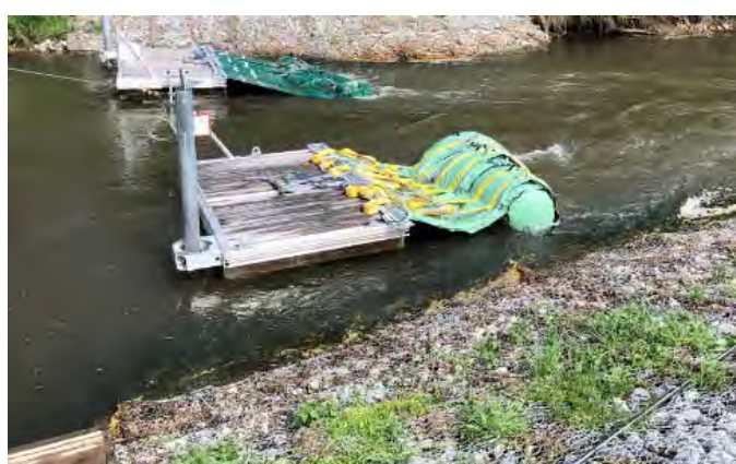
Gurt-System funktioniert wie geplant, aber...
