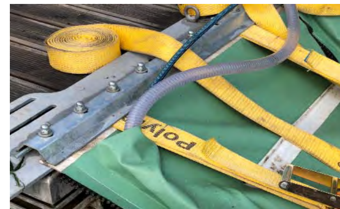
Gurtsystem an Klemmschiene verankert
