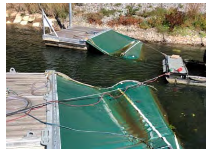
1 - Segment - Buhnen im Betrieb
