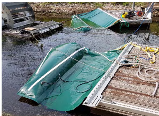
Befüllung der optimierten Buhne
