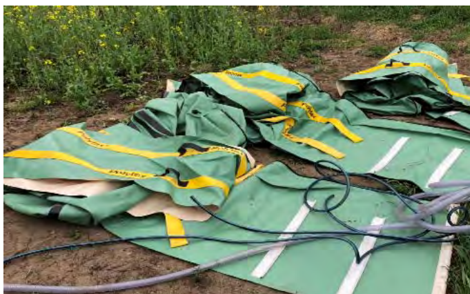
Vormontage optimierte Buhne 2
