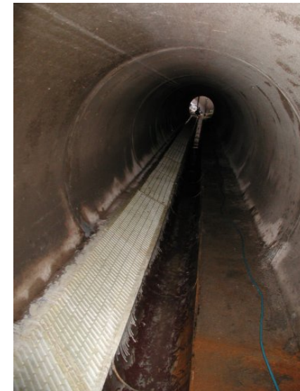
Gestickter Inliner im Abwasserkanal
